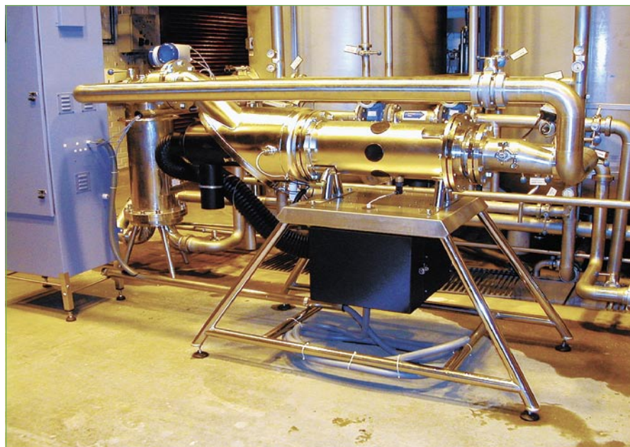
Рис. 3. Установка R-200 (с одной лампой) для гидрооптического обеззараживания воды
